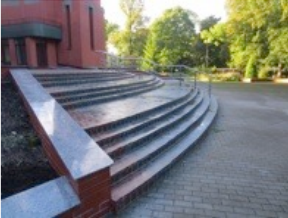
Neue Treppe zur Auferstehungskirche Kaliningrad. Hier half uns die große Spende der ev. reformierten Gemeinde Ittigen/ Schweiz zu einer Grundsanierung.
